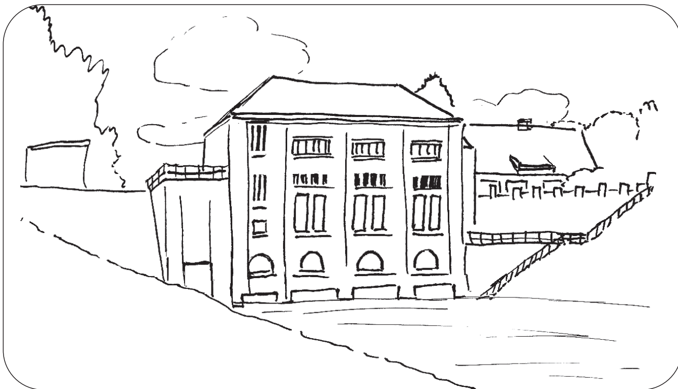
Elektrownia w Borowie
